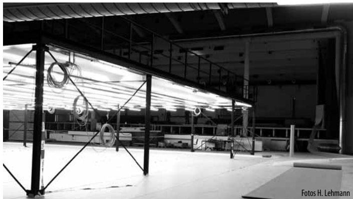
Erdgeschoss: Stahlskelett-Struktur in die die geschlossenen Kabinen gestellt werden; Im Hintergrund die Tribüne, die den Sanitärbereich aufnehmen wird.
