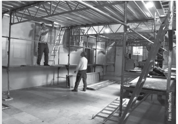
St. Ottilien wird saniert...
